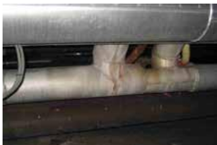
Digital- und Wärmebild einer der Rohrleitungen im Netzwerk. Auf dem Wärmebild ist die fehlerhafte Isolierung eindeutig erkennbar.
