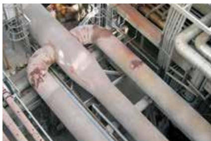
Digital- und Wärmebild einer schadhafte Feuerfestauskleidung in einer Luftleitung
