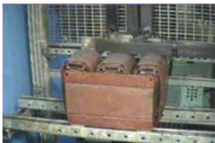
Digital- und Wärmebild eines dreiphasigen Transformators
