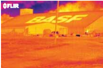
BASF setzt Wärmebildkameras schon seit langer Zeit ein.
