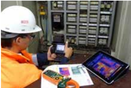
Die FLIR Wärmebildkamera überträgt die thermischen Daten per Wireless LAN zu einem Tablet PC.
