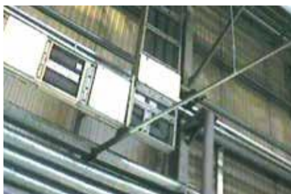
Digital- und Wärmebild eines Verteilerschienensystems in der Produktionshalle
