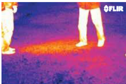
Mit einer Wärmebildkamera ist die genaue Position des Lecks gut auszumachen.
