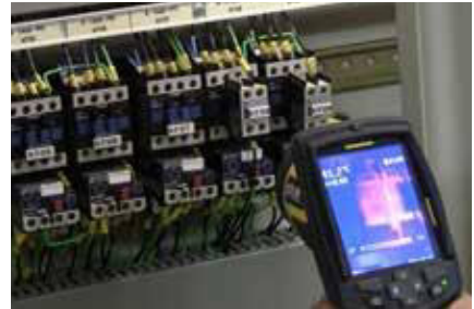
Untersuchung einer Sicherung in einem elektrischen Schaltschrank
