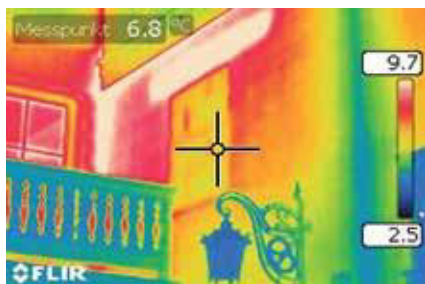
Ein ehemaliges Fenster - mit Backsteinen oder Putz in besserer Qualität zugemauert
