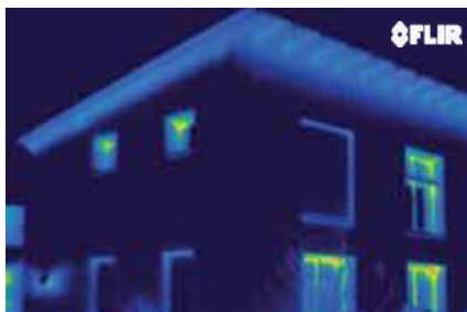
Das Wärmebild zeigt die Dämmungsqualität eines Niedrigenergiehauses.
