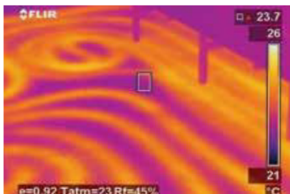
Eine FLIR Wärmebildkamera ist auch ein hervorragendes Werkzeug, um Fußbodenheizungen sichtbar zu machen.
