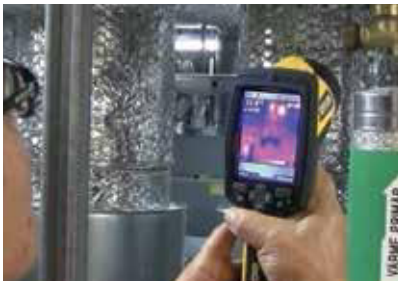
FLIR Wärmebildkameras lassen sich einsetzen, um eine große Zahl unterschiedlicher Gebäudeprobleme zu entdecken, die im Zusammenhang mit Wärme stehen.
